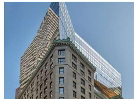
La angulada y volada “caja de joyas” y el sofito de plástico de fibra de vidrio reforzado diseñado a la medida por Arrowstreet se dobla hacia adentro en el punto exacto en el que las fachadas de los edificios de 1904 y 1906 se conectan por debajo.
